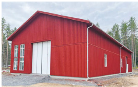
Rödfärgskulturs nayagarage och maskinhall där målningsarbeten görs.
