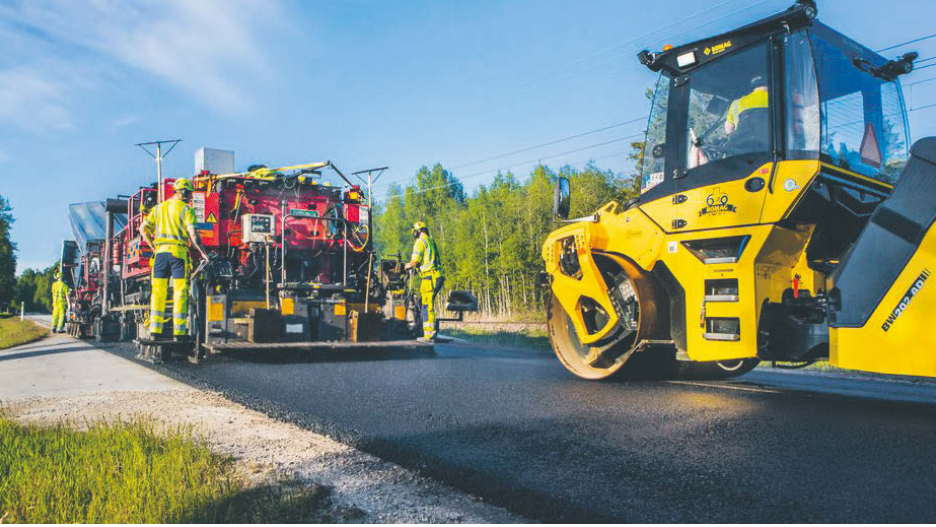
I Sverige pågår en historiskt omfattande satsning på vägunderhåll. Foto: Trafikverket
