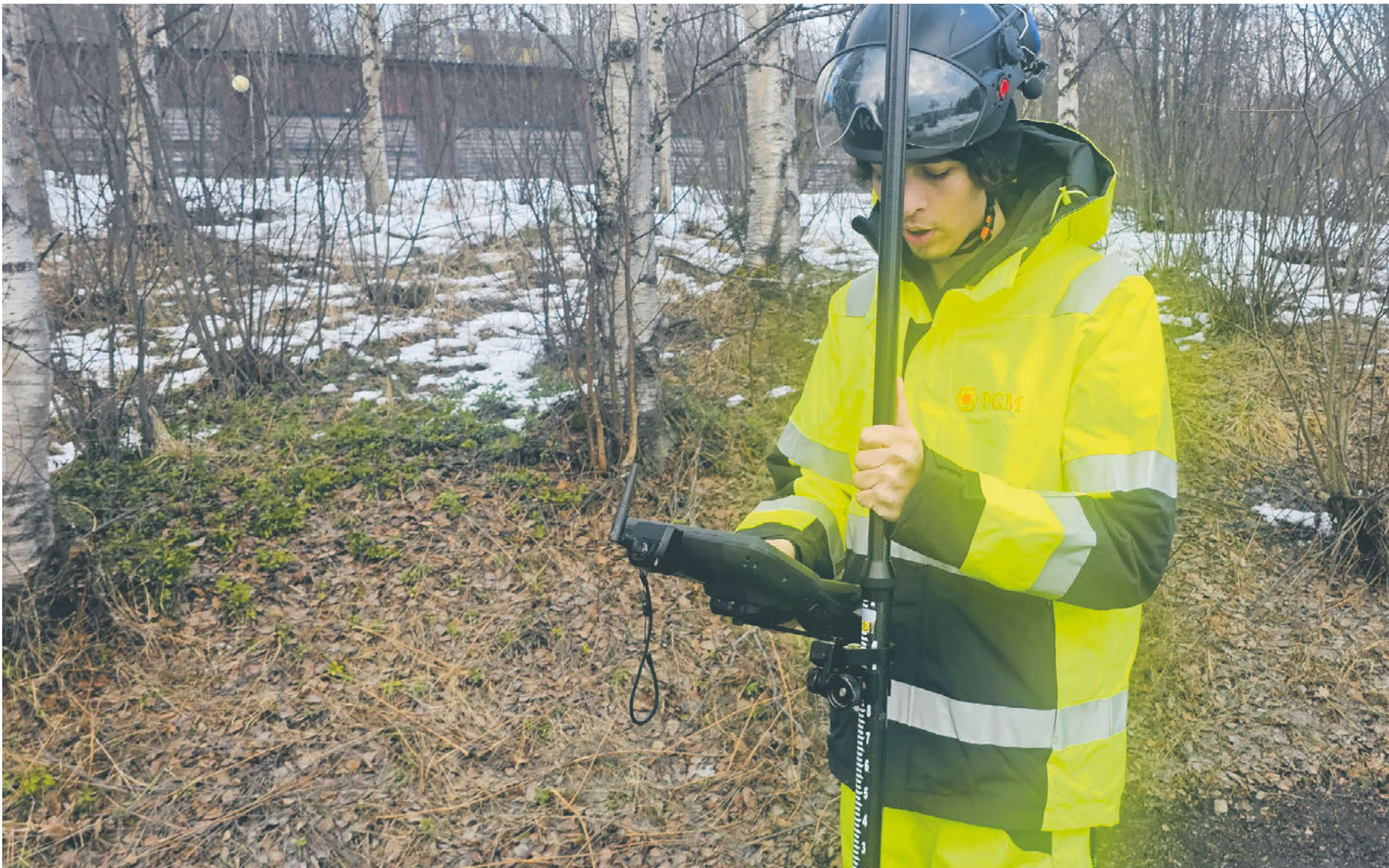
Josef Johnsson på PGM AB arbetar med mätteknik inom bygg och anläggning. Genom noggranna inmätningar och utsättningar skapar de förutsättningar för säkra och effektiva byggprojekt. Foto: PGM AB
